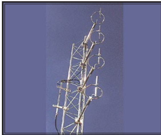
Gambar 2.10 : Antena OMB dipasang pada tower
